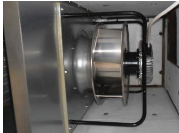
Uudistunut tuloilmakone valmiina käyttöön- ottoon. Sääötapoina voidaan käyttää VAK:ia, portaatonta manuaalisäätöä 0-10 VDC potentiometrillä tai 2-nopeussäätöä kahdella 0-10 VDC potentiometrillä / kello-ohjaus.
