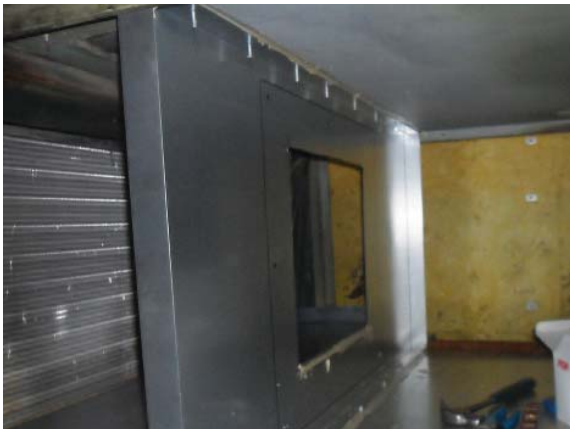
Kammioon on asennettu väliseinä uutta EC-kammiopuhallinta varten. Huomioi, että patterin ja imuaukon väli on 0,5 \times D . D-mitta on siiven ulkohalkaisija.
